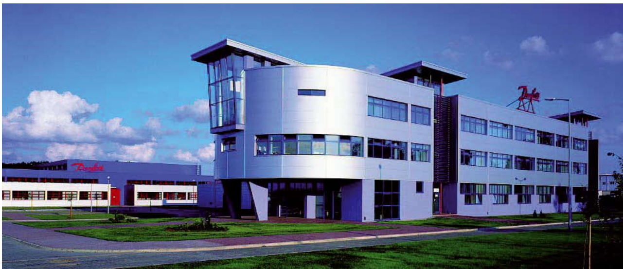
Kompleks biurowo - produkcyjny w Grodzisku Mazowieckim
